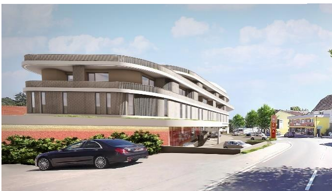
Ansicht Passauerstraße Richtung Ortszentrum
