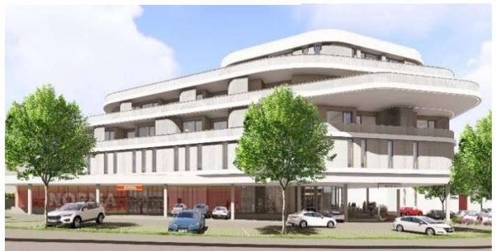
Ansicht bei Kreisverkehr
